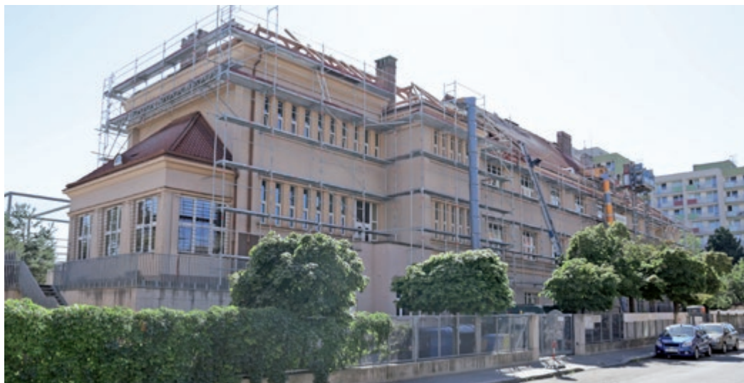
Budování nástavby na ZŠ Jarov začalo rozebíráním střeby
