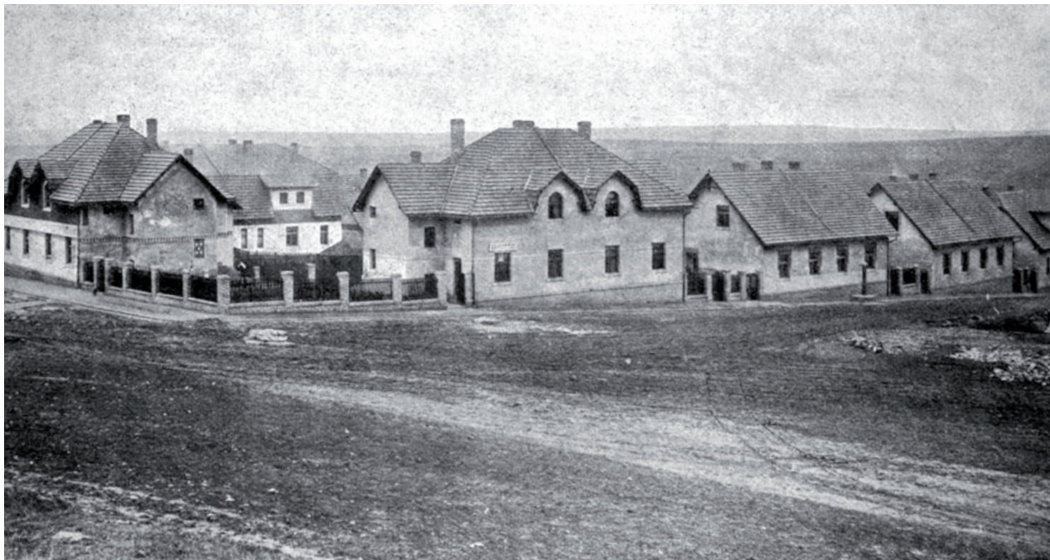
Celkový pohled na jeden blok dostavěných domů
