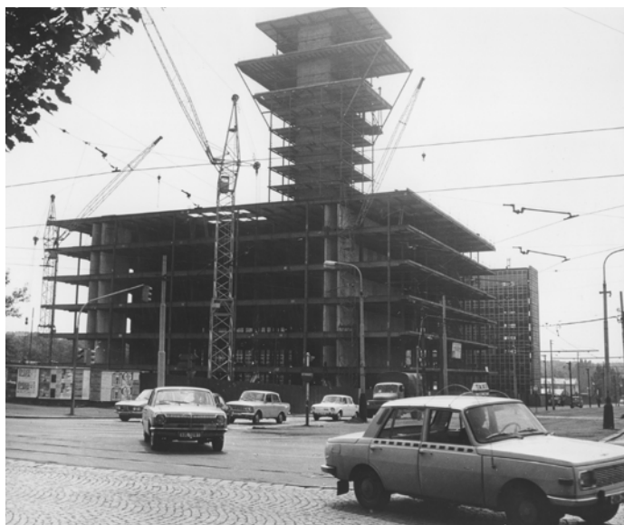
Záběr staveniště z června 1975
