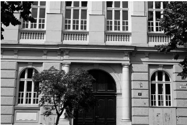
Nově opravená okna ZŠ Jiřího z Poděbrad
