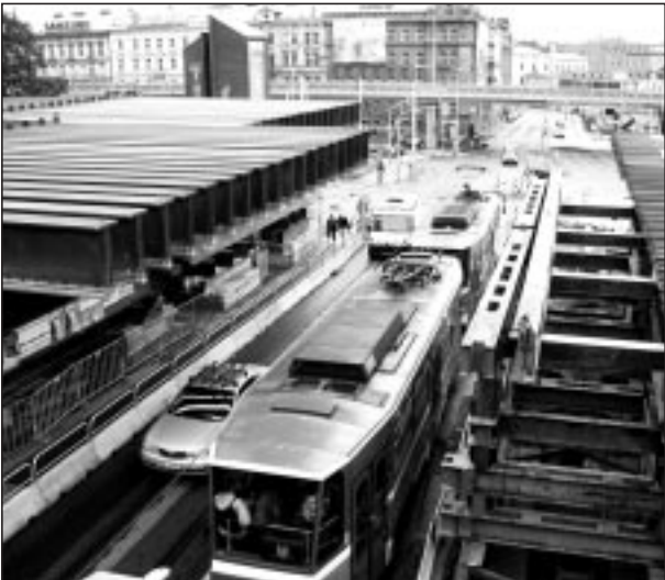
Vysouvání ocelové části nosné konstrukce přes ulici při zachování provozu pod mostem, foto pořízeno 12.-14. 8.
