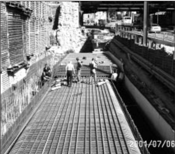
Armování severní opěry mostu, foto ze začátku července
