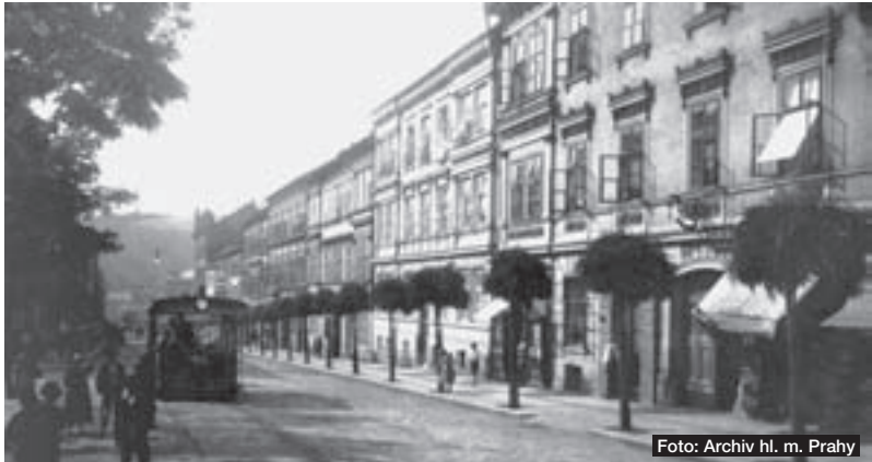
Pohled do Prokopovy ulice na Žižkově (kolem r. 1900)
