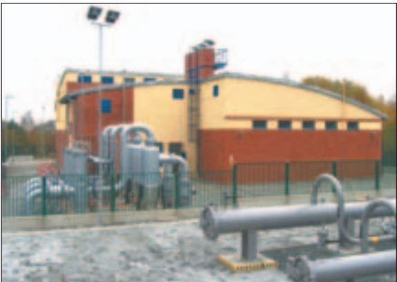
V Horních Měcholupech byla v loňském roce uvedena do provozu nová velmi vysokotlaká regulační stanice, která je nejvýkonnější v České republice a patří k největším zařízením svého druhu v Evropě. Byla postavena z důvodu kvalitnějšího zásobování obyvatel hlavního města zemním plynem.
