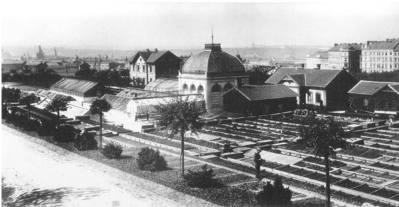
Rajská zahrada tvořila základ přestěhované zásobní zahrady pod Vrchem sv. Kříže
