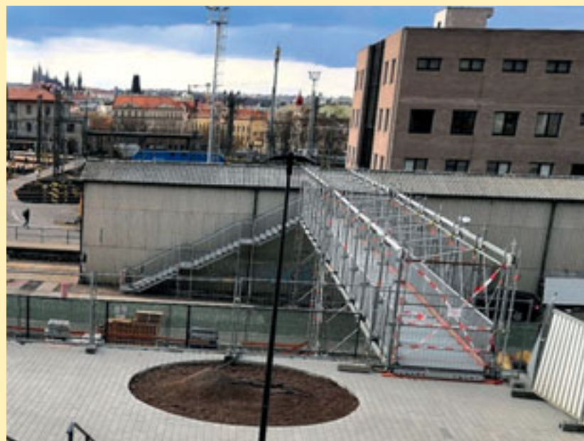
Provizorní přechod je nyní součástí staveniště. foto Metro
