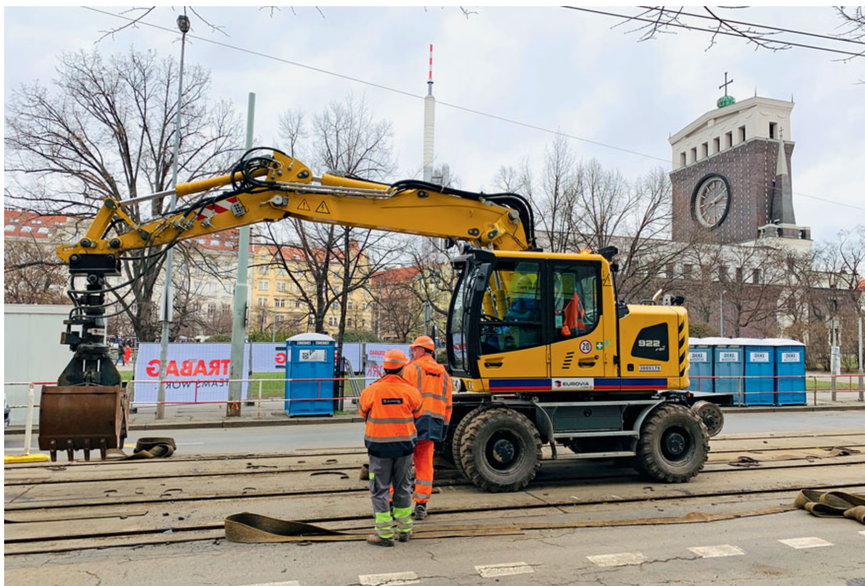
Začala rekonstrukce Vinohradské ulice
