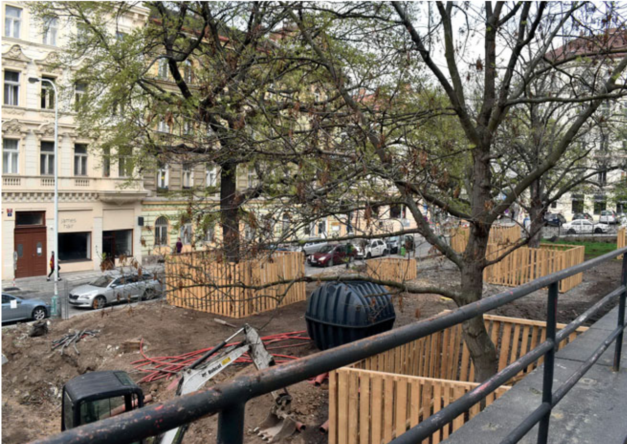
Rekonstrukční práce na Kostnickém náměstí jsou v plném proudu
