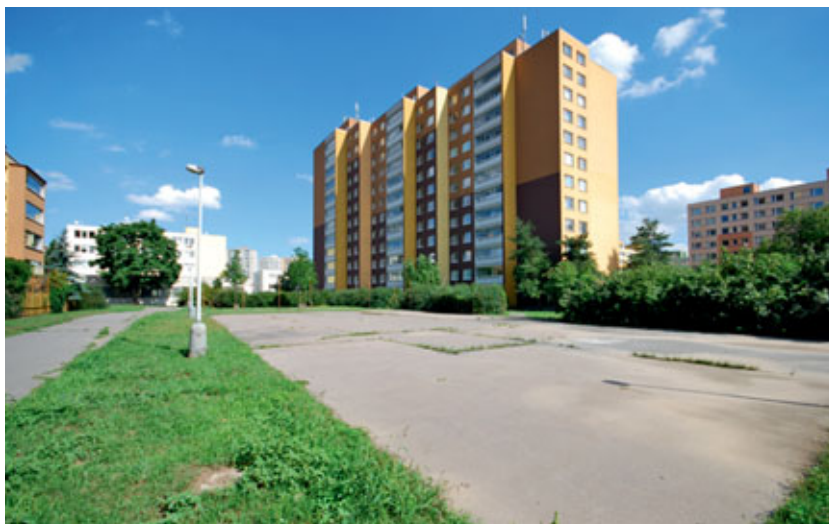
Ulice Na Jarově/Úprava hřiště
