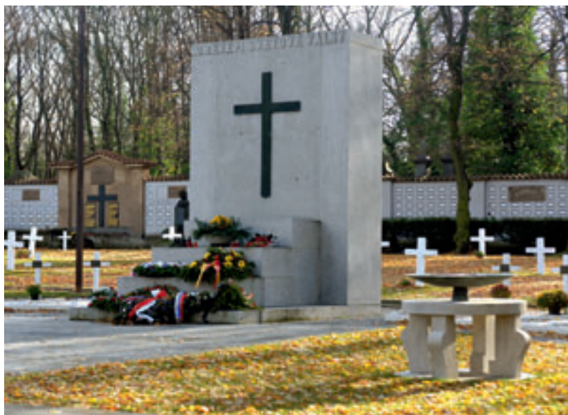
Nově zrenovované ossarium
