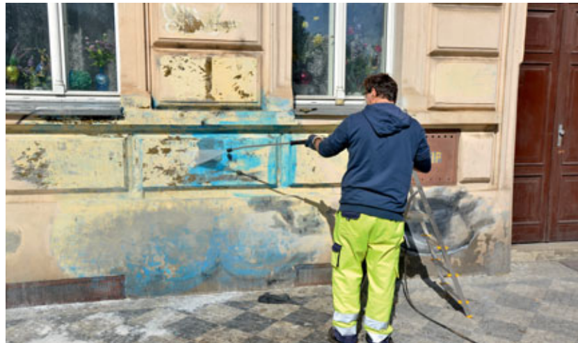
Při odstraňování graffiti se postupuje s maximální šetrností vůči fasádám domů.
