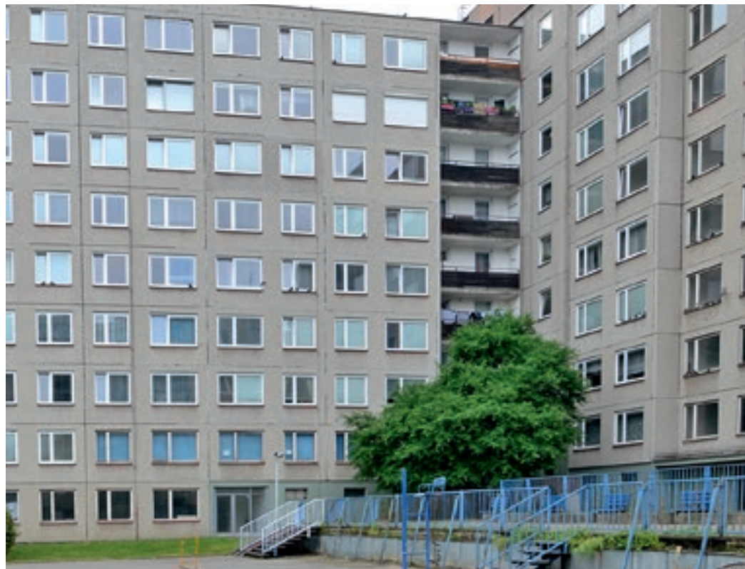
Panelový dům před rekonstrukcí
