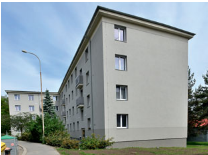
Rekonstruované domy v Bukové ulici
