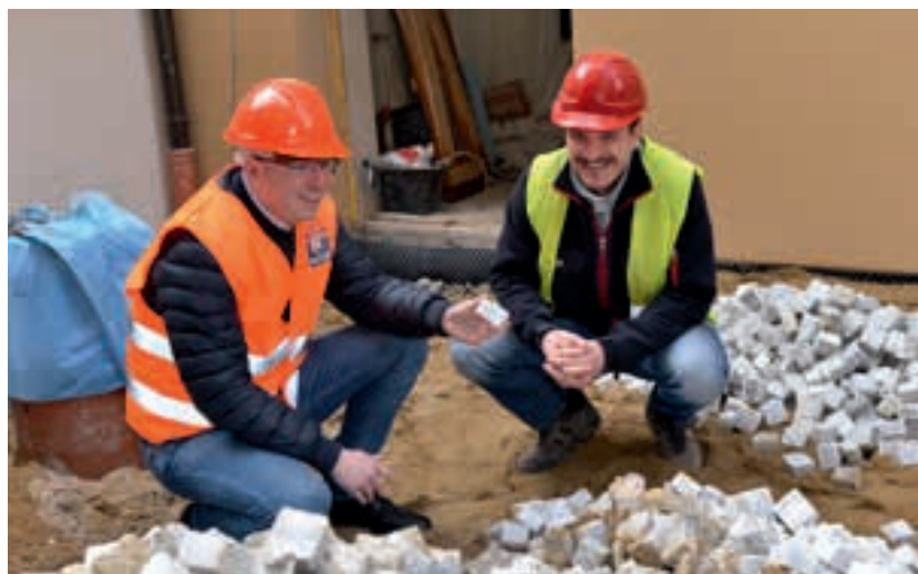
Zástupce starostky Ivan Holeček (vlevo) při obhlídce staveniště se stavbyvedoucím Pavlem Huňou
