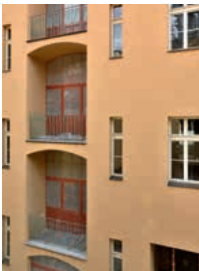
Objekt v Bořivojově ulici po úpravách
