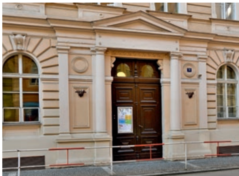
Nový nátěr zakryl poškození způsobené vandaly
