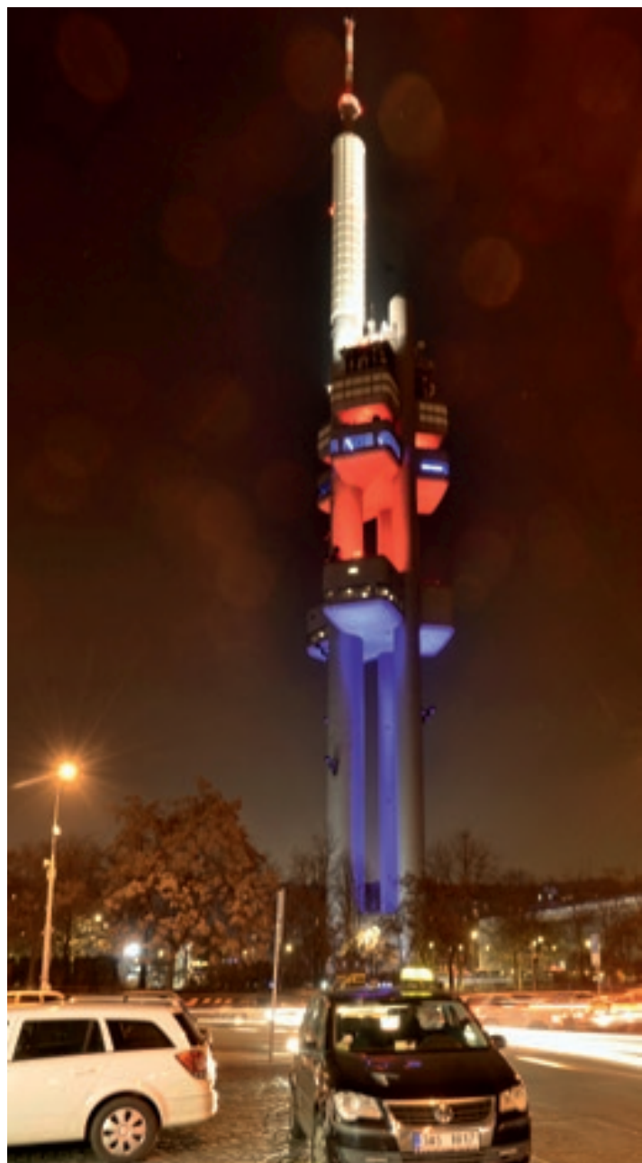
Žižkovská televizní věž
