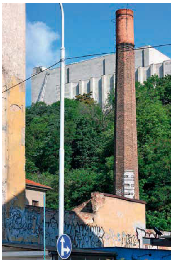
Pozůstatky tovární společnosti Schimmel & Comp. na éterické oleje
