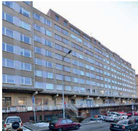
Stavební úpravy domů v Roháčově ulici 34-42 jsou předmětem výběrového řízení
