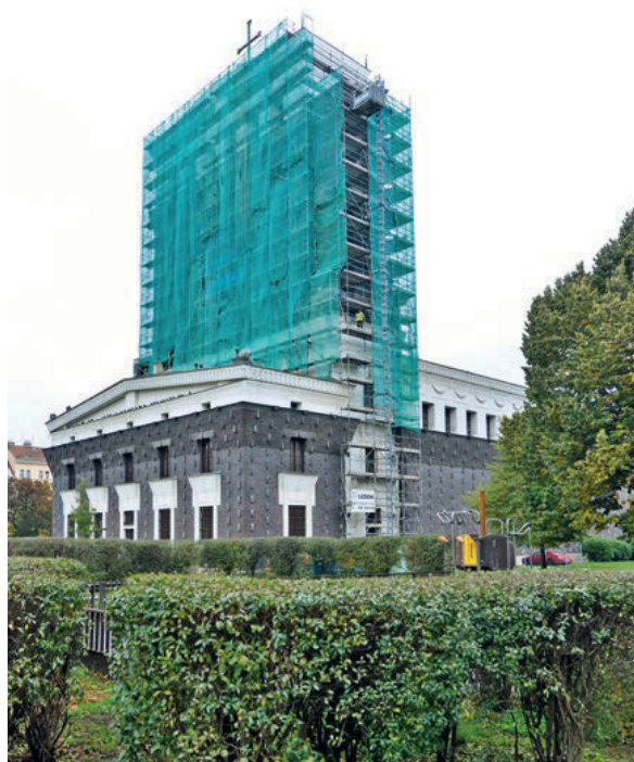
Čištění a oprava spárování keramického obkladu severní věžice
