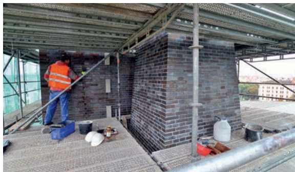
Čištění a oprava spárování keramického obkladu severní věžice
