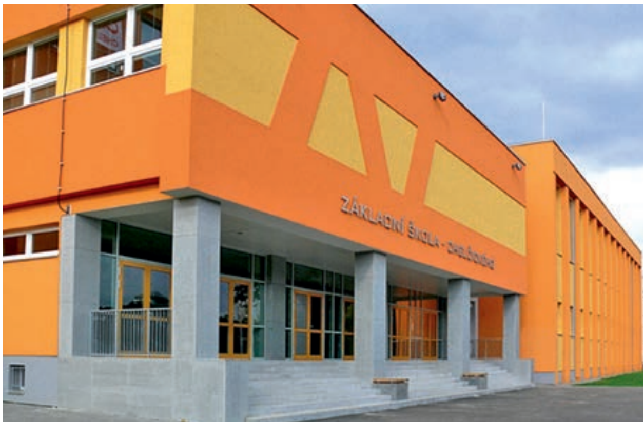
ZŠ Chelčického čeká rekonstrukce střechy
