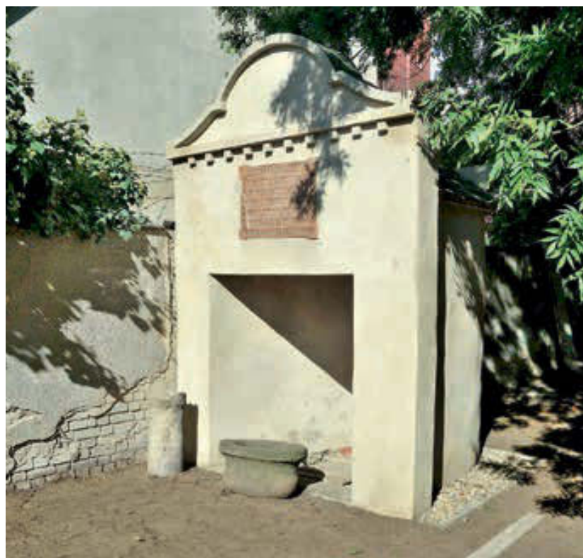
Zappertova studna po částečné opravě
