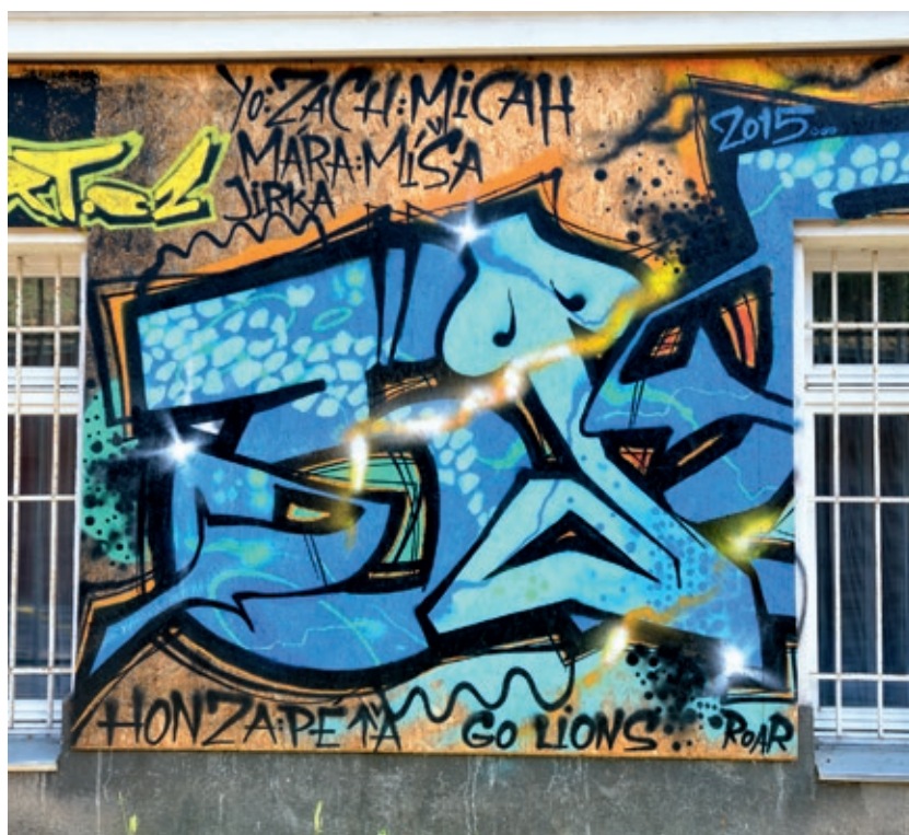
Praha 3 bude čistit fasády poškozené vandaly
