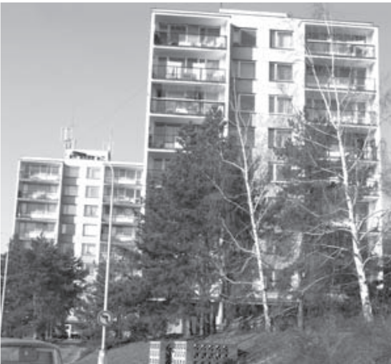
PANELÁKY V ULICI POD LIPAMI se již brzy dočkají nových zateplených fasád, střech, oken a balkonů. Vylepšeny budou interiéry společných prostor, počítá se s rekonstrukcí bytových jader, s výměnou elektrických rozvodů, opraveny budou výtahy a schodiště.
