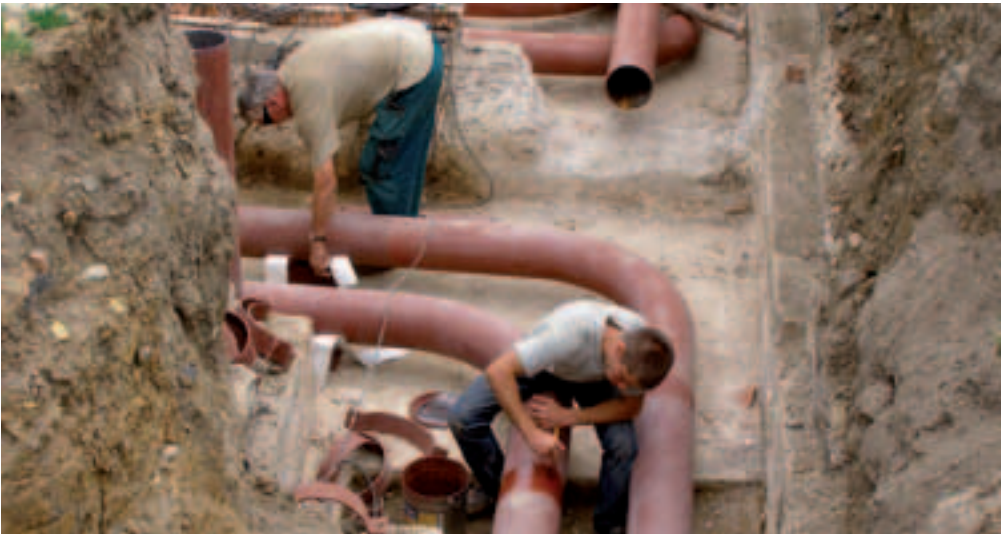
Během odstávek se provádí jak běžná údržba, tak i náročnější opravy teplárenských zařízení
