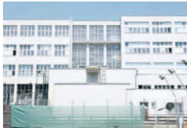
Opravy se dočká i prosklená stěna architektonicky cenné budovy Základní školy náměstí Jiřího z Lobkovic.
