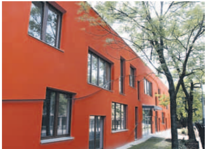
Po roční rekonstrukci se po prázdninách otevře Mateřská škola U Zásobní zahrady.
