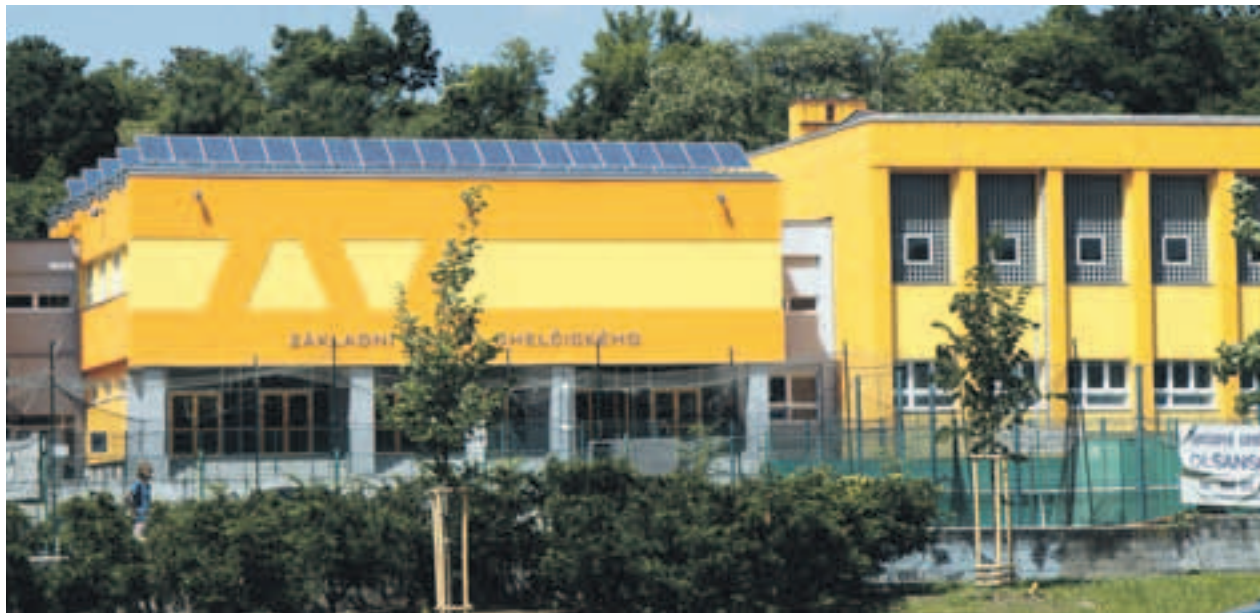
Fotovoltaické články na střeše Základní školy Chelčického.
