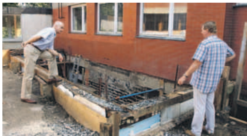
Zástupce starosty Jiří Matušek (vlevo) a vedoucí Odboru školství Přemysl Hrabě při kontrolním dni v právě rekonstruované MŠ Vozová
