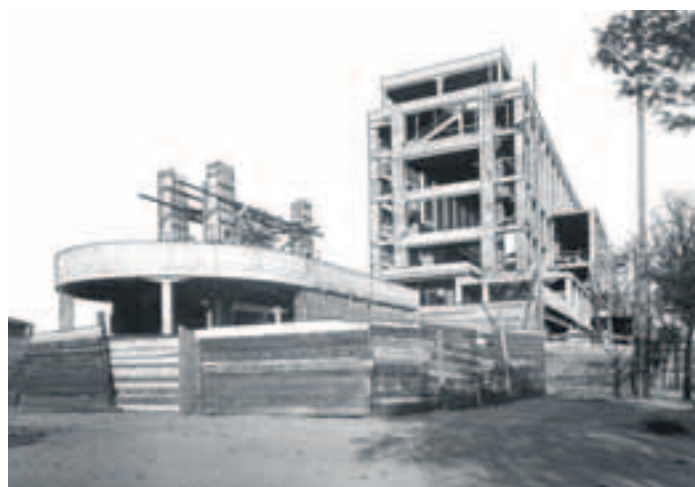
Stavba Národního památníku na Vítkově
