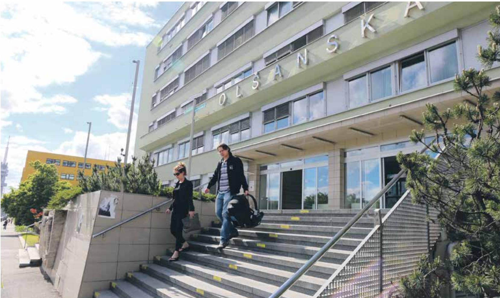
Domovní správy Prahy 3 se od 1. července sestěhují do budovy v ulici Olšanská 7
