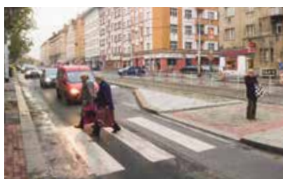
Nové přechody v Koněvově ulici
