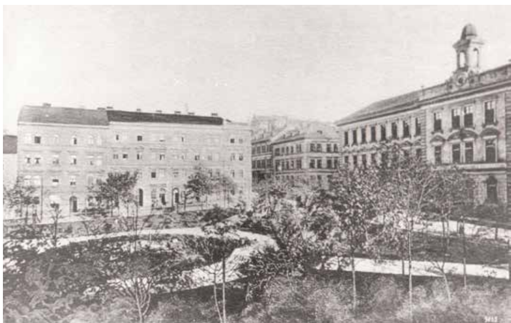
Komenského náměstí vždy lemovaly bytové domy, kterým dominovala budova školy...
