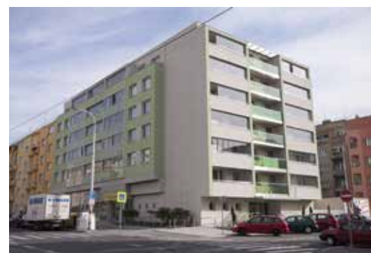
V přízemí a suterénu budovy v ulici Za Žižkovskou vozovnou 18 vznikne spolu s knihovnou nové kulturní centrum
