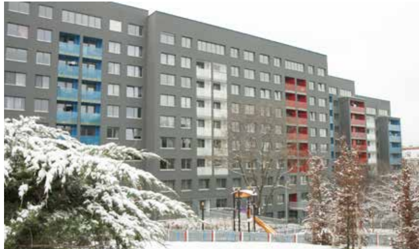
Nákladnou rekonstrukci bytového domu v Lupáčově ulici řeší na základě trestního oznámení policie
