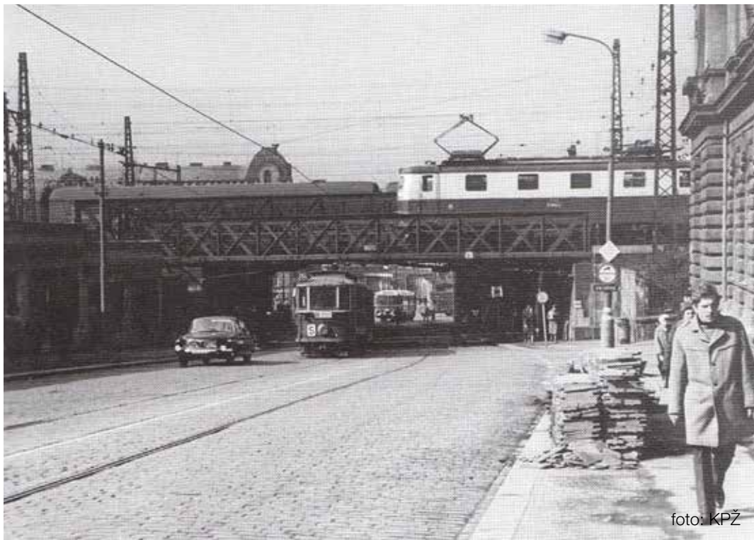
Mosty nad Seifertovou ulicí přiváděly železniční dopravu na hlavní nádraží
