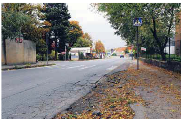
Malešická ulice se po dlouhých letech konečně dočkala celkové rekonstrukce.
