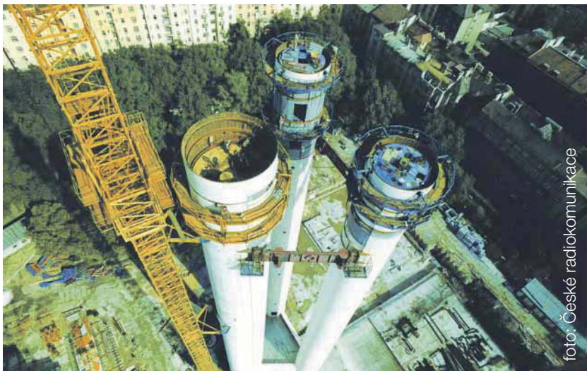
Žižkovská věž byla postavena v letech 1985–1992
