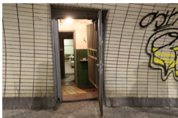
Vchod do krytu z žižkovského tunelu
