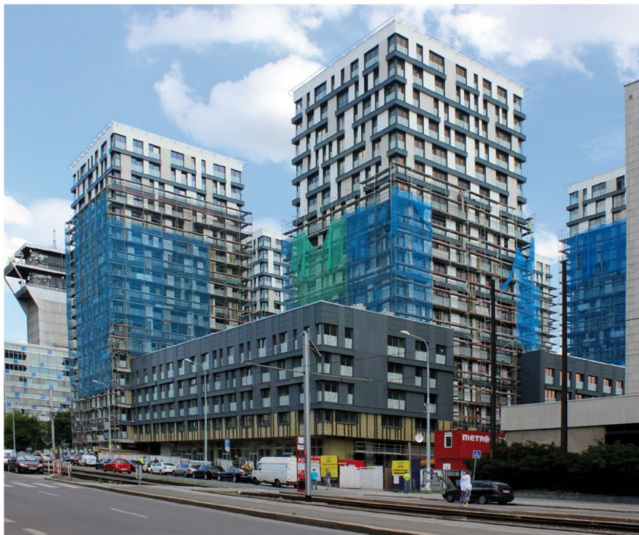
Novostavba multifunkčního areálu Garden Towers v Olšanské ulici. Stav v červnu 2016.
