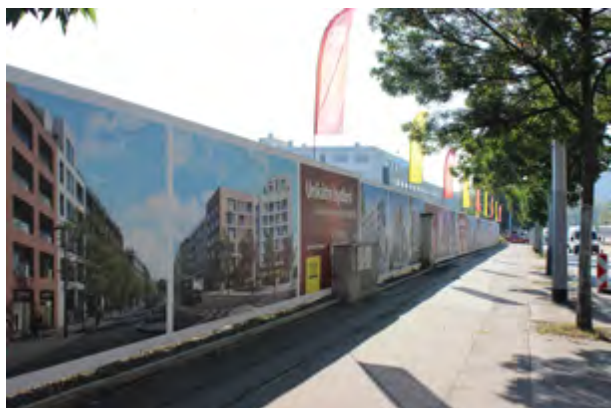
Staveniště – Nákladové nádraží Žižkov – nejen nové bydlení
