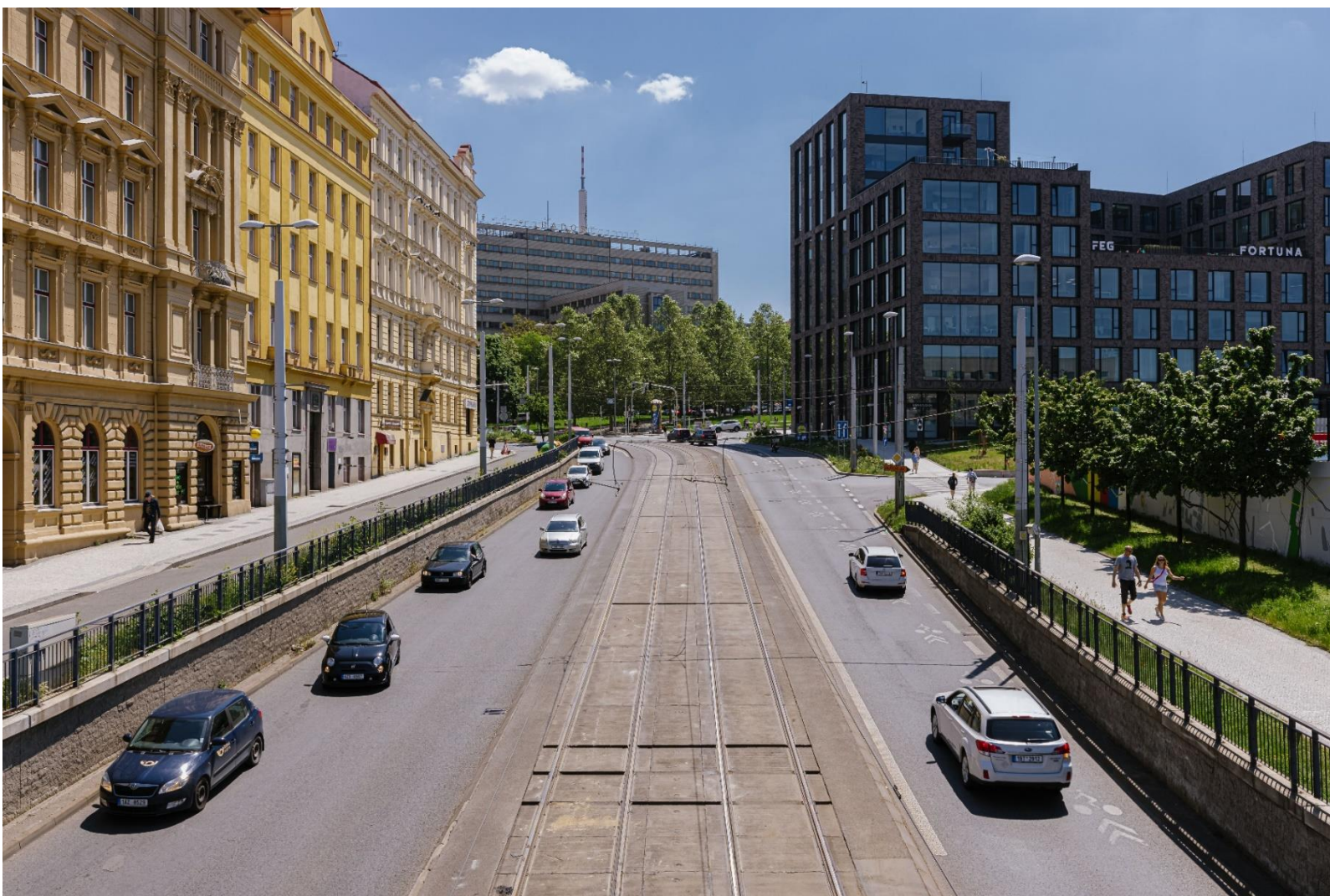
Dolní část Seifertovy ulice – pohled od železničního podjezdu směrem k domu Radost v pozadí. Foto IPR Praha.
