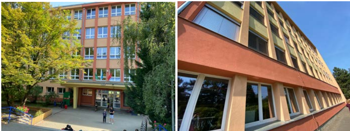
Obrázky: Pohled na budovu školy od hlavního vchod, fasáda školy ze zadní strany budovy – tepelně izolovaná, izolační okna a předokenní žaluzie.
