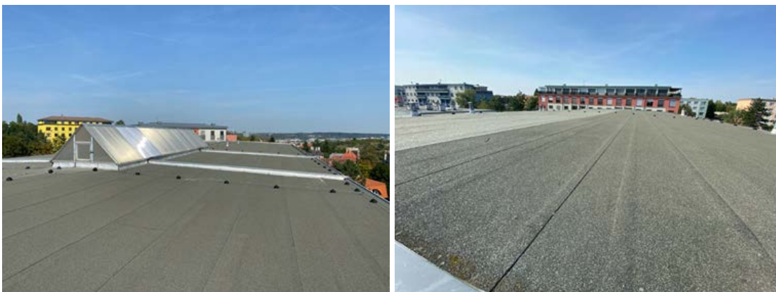
Obrázky: Pohledy na střechu, kde by mohla být umístěna fotovoltaická elektrárna.
